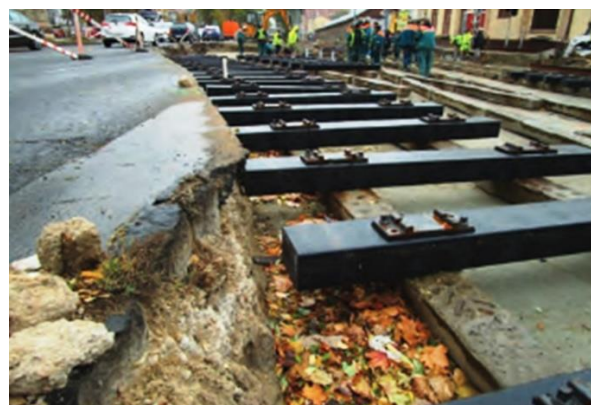
Fig. 84 Plastoŝpaloj en tramtrako en Budapeŝto (Foto: Sínek Világa 2021/6)
