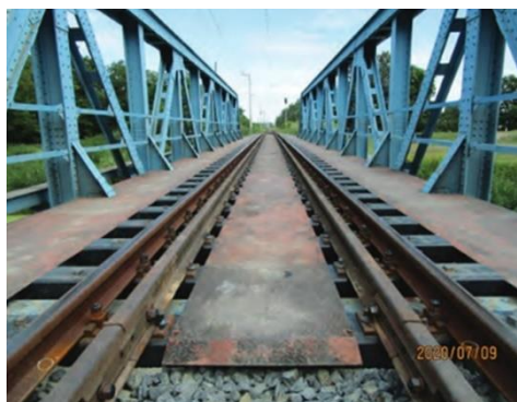
Fig. 80 Muntado de plastotraboj sur la ŝtalponto (Foto: Sínek Világa 2021/6)
