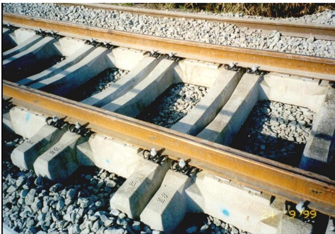
Fig 41 La aŭstra latisa betonŝpalo en la trako sen balasto. (Foto: Dr. Kazinczy László)
