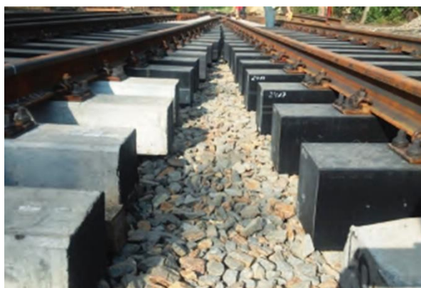
Fig. 83 Plastoŝpaloj en traknivela trapasejo en Hódmezővásárhely (Foto: Sínek Világa 2021/6)
