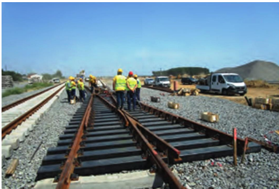
Fig. 85 Plastoŝpaloj en trakforko en stacio Fényeslitke (Foto: Sínek Világa 2021/6)
